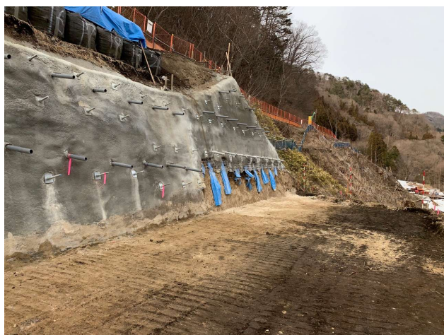
進入路(起点側)
