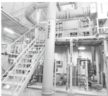
場内より発生する臭気を濃度別に捕集し、適正に脱臭処理を行います。今回改修工事では、活性炭触媒を用いて臭気を効率的に脱臭することができる酸・アルカリカーボン洗浄塔を採用しました。
