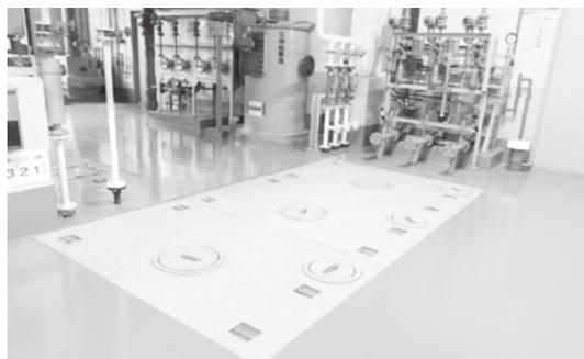
生物処理によりBOD（有機物）と窒素化合物を除去した後、膜分離設備により固液分離を行い、後段の高度処理にSS分を除去した処理水を送ります。膜分離設備は、微多孔性膜を用いてSS分を透過させず、きれいな処理水を安定して得られます。今回改修工事では老朽化が進んでいた設備を更新しました。
