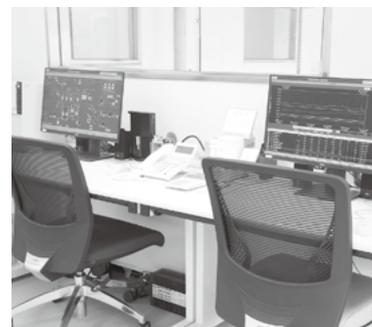
施設内の受入から放流までの全ての設備の運転状況を監視しています。経年劣化が進んでいたシステム機器を最新の機種とし、省エネ自動運転制御にも対応した設備に更新しました。
