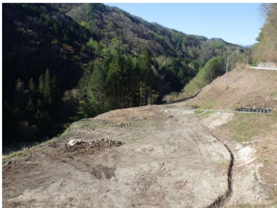
伐採（施工ヤード）
