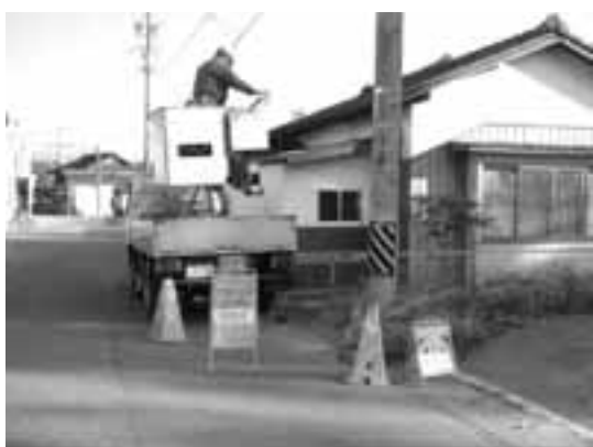
電柱共架作業の様子
