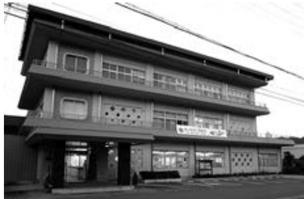
外壁等改修工事が行われた役場庁舎
