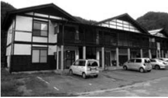
外壁屋根塗装工事が行われた中の瀬団地
