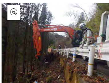
⑥ 【抜根】 抜根します。
