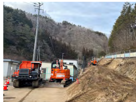
村道区間①下流 掘削 2024年2月9日
