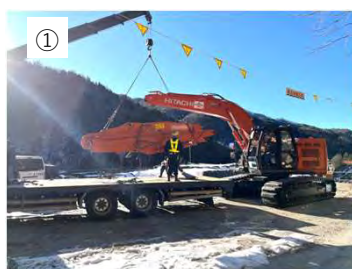
① 【スライドアーム組立】 夜のうちに搬入しました。 朝から組み立てます。
