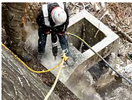
村道区間⑤ 既設排水切廻し 2024年2月1日
