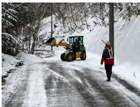
村道区間② 除雪 2024年2月5日
