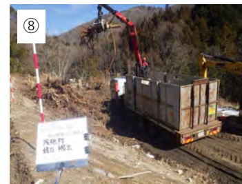
⑦ 【抜根材搬出】 抜根した木の根は産廃として搬出して処分します。
