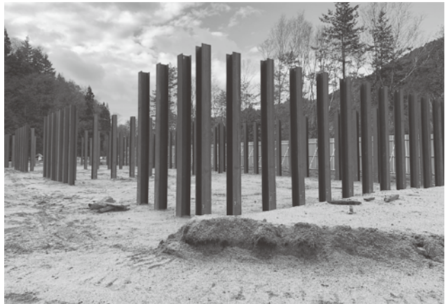
広瀬非常口の土砂ピット
