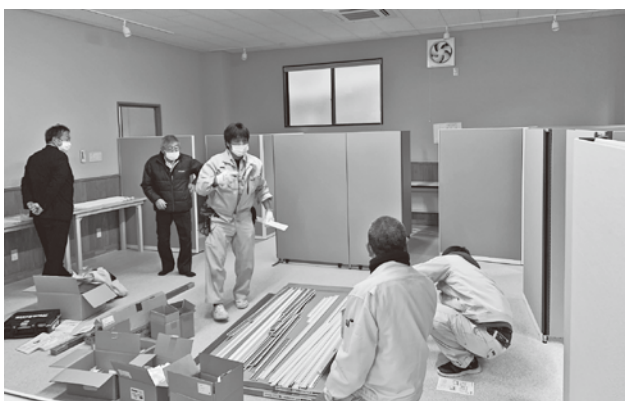
改修中のテレワーク施設
