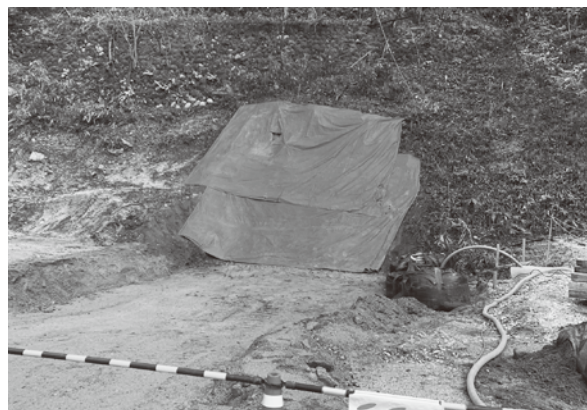
広瀬非常口掘削予定地
