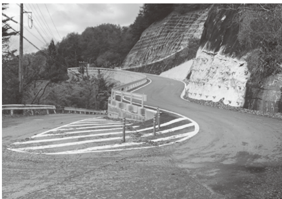
リニア工事に伴い改良された道路
