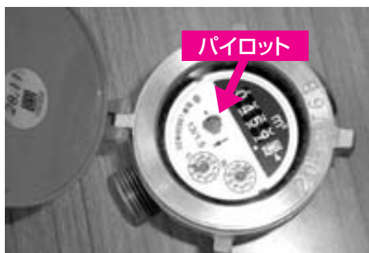
水を使用していないときにパイロットが動いてい れば漏水です(図1)
