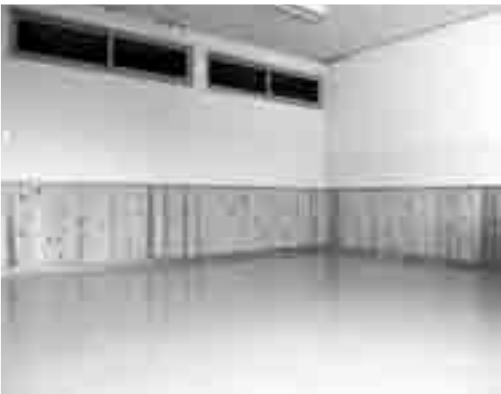
改修された公民館会議室
