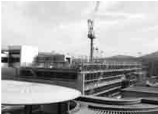
工事中の統合中学校
