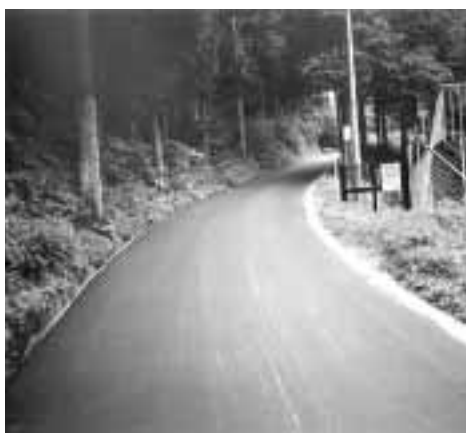
青見平 道路舗装
