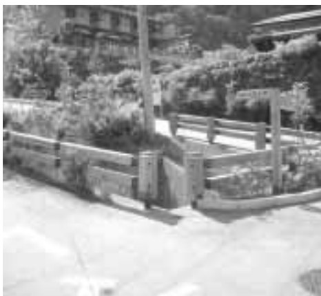
木製ガードレール
